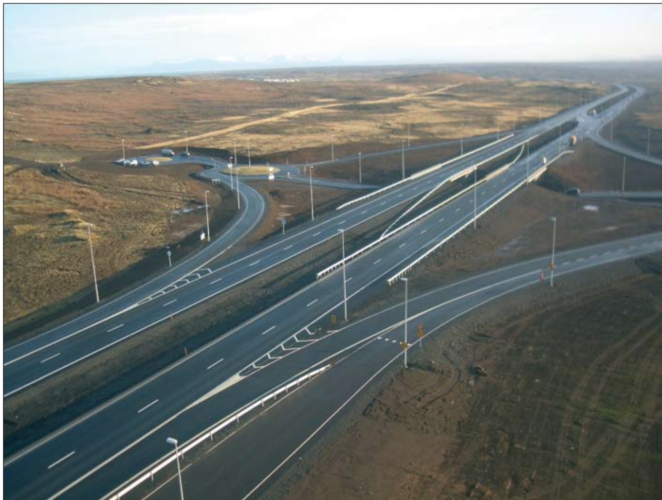
Mislæg gatnamót Reykjanesbrautar og Grindavíkurvegar. Ljósmynd: Trausti Bjarnason verkstjóri hjá Ístak.
