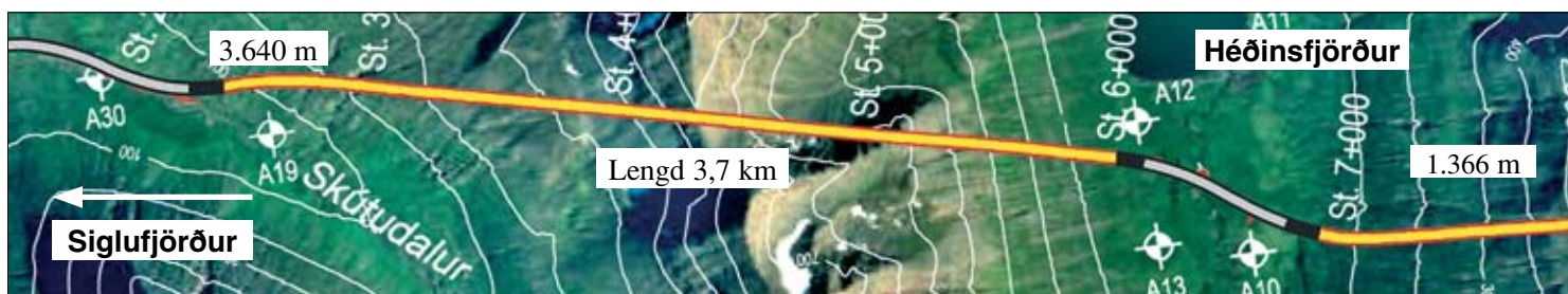
Staða framkvæmda við Héðinsfjarðargöng 20. okt. 2008. Sprengingum frá Siglufirði til Héðinsfjarðar lauk 21. mars 2008.
